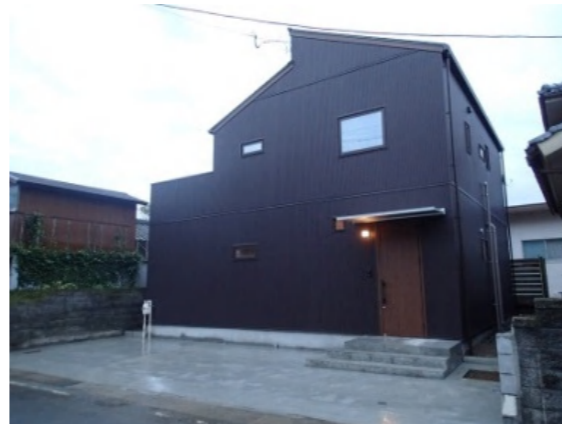
←屋根の改修と一部撤去。外壁金属サイディング貼りとし建物の軽量化を図りスッキリとした佇まいに。
