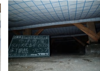
↓間仕切りに筋かいを新設し、柱を金物で補強。床下への断熱施工（セルローズファイバー）
