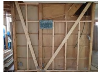
↓間仕切りに筋かいを新設し、柱を金物で補強。床下への断熱施工（セルローズファイバー）
